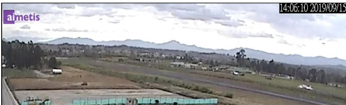
Fotografía No. 32: Desplazamiento horizontal y Altura sobre la pista
